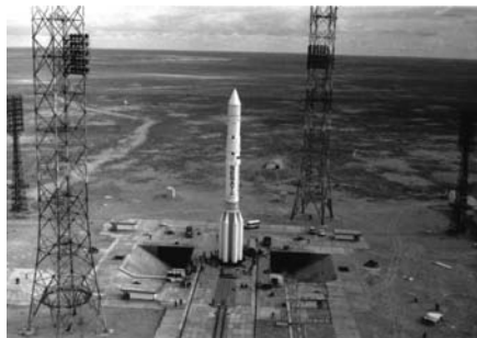
Рис. 8.1.15. Стартовое сооружение с установленной на стартовую систему РН «Протон-К» (Байконур)
