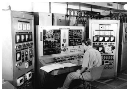
Рис. 8.1.25. Пульта и стойки системы дистанционно автоматического управления заправкой РКН «Протон-К» компонентами топлива и газами
