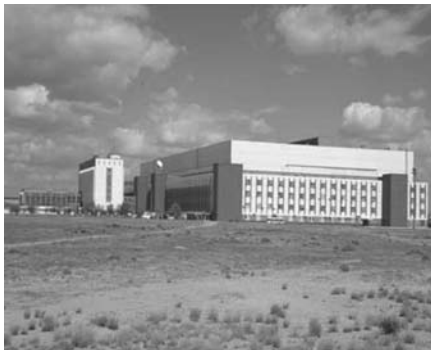
Рис. 7.2.8. Монтажно-испытательный корпус технической позиции подготовки изделий РКТ на космодроме запуска
