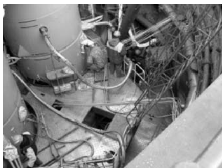
Рис. 8.1.23. Стыковка в ручном режиме заправочных коммуникаций к РКН «Союз»
